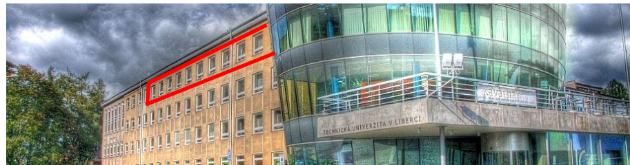
Budova E1, 4. NP
